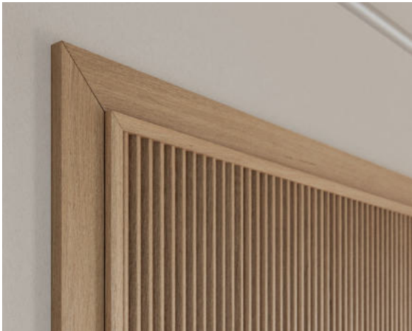
Łączenie opaski ościeżnicy pod kątem 45°
